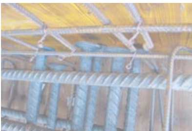
Verankerung mit ancoFIX®-Bewehrungen Ancrage avec l'armature ancoFIX®
