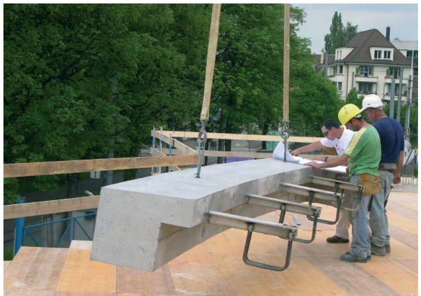
Versetzarbeiten der vorgefertigten Dachrandelemente. Éléments préfabriqués en béton posés avant le bétonnage de la dalle.
