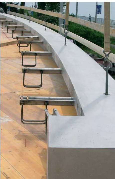
Versetzarbeiten der vorgefertigten Dachrandelemente. Éléments préfabriqués en béton posés avant le bétonnage de la dalle.
