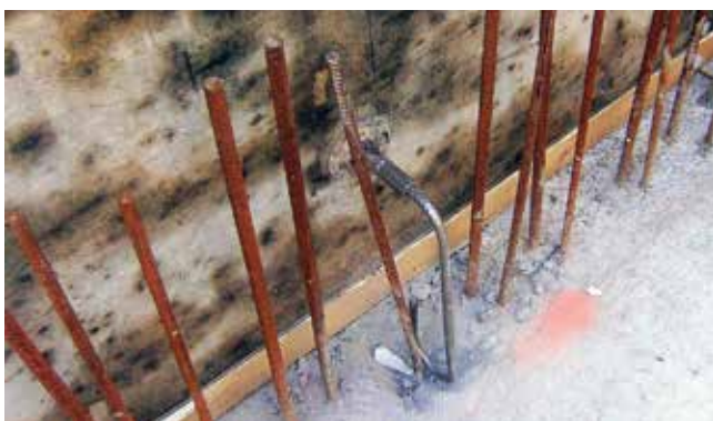
Zuganker im Einsatz auf der Baustelle. Ancre de traction en utilisation sur le chantier.
