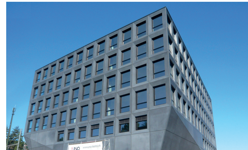
UNO Geschäfts- und Bürogebäude in Liestal
