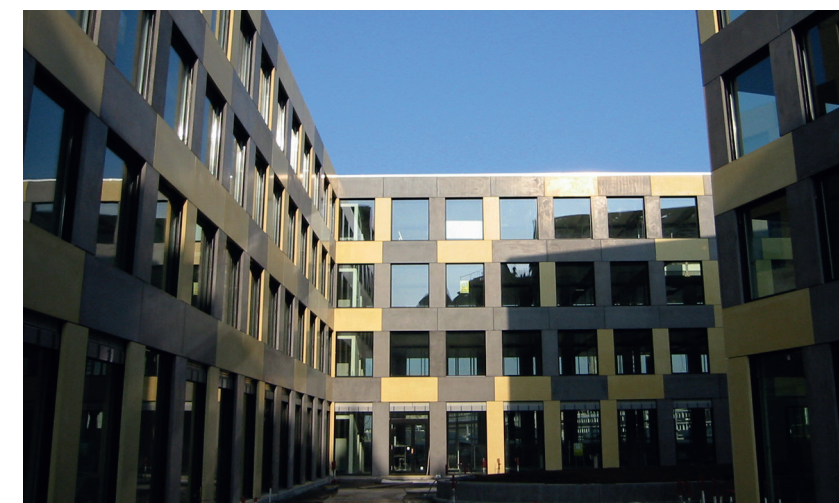
Geschäftshaus St. Leonard in St. Gallen
