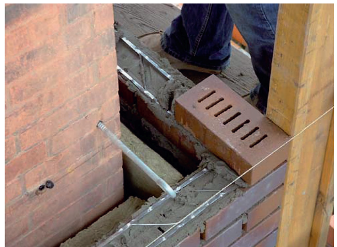
Mit MURINOX®-Lagerfugenbewehrung verstärktes Mauerwerk. Armature de joint d'assise MURINOX® pour mur linéaire et d'angle.
