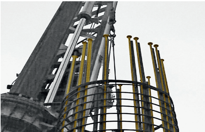
Pfahlkopfdetail in Fahrbahnplatte Encastrement de pieux d'une dalle de roulement
