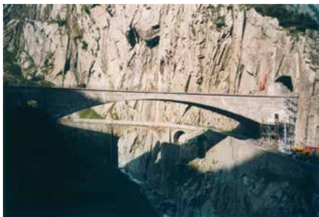
Sanierung Teufelsbrücke im Kanton Uri
