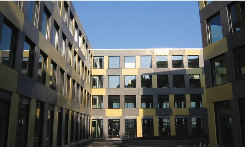
Geschäftshaus St. Leonard in St. Gallen
