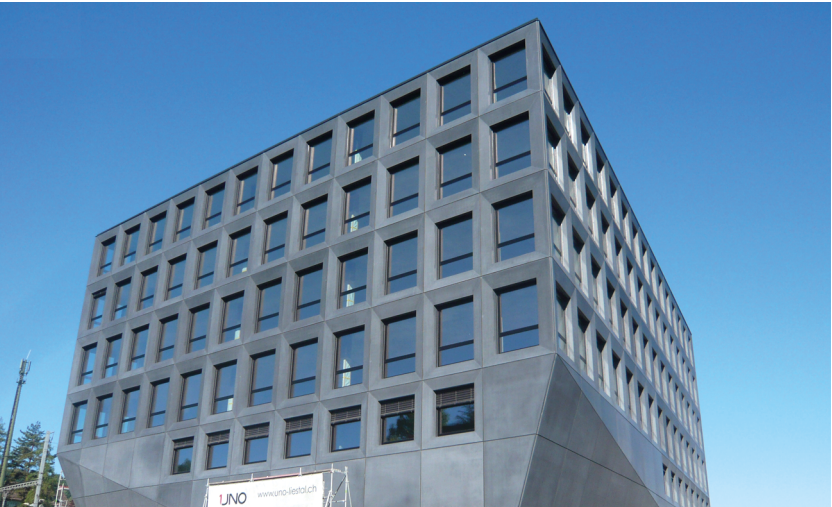
UNO Geschäfts- und Bürogebäude in Liestal
