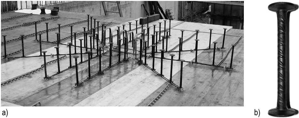
Figure 1: Système ancoPLUS: (a) ensemble de pièces; et (b) détail d'un goujon Pour faciliter le montage, les goujons sont reliés à une extrémité par une ou deux barres de petit diamètre ou bien par un fer plat. Grâce à ce système, les pièces ancoPLUS peuvent être placées sur l'armature de flexion d'une dalle ou d'un radier avant son bétonnage. Un aperçu des armatures ancoPLUS ainsi que d'un goujon est montré à la Figure 1.Plus de détails du système ancoPLUS peuvent être trouvés dans la description du produit [14].
