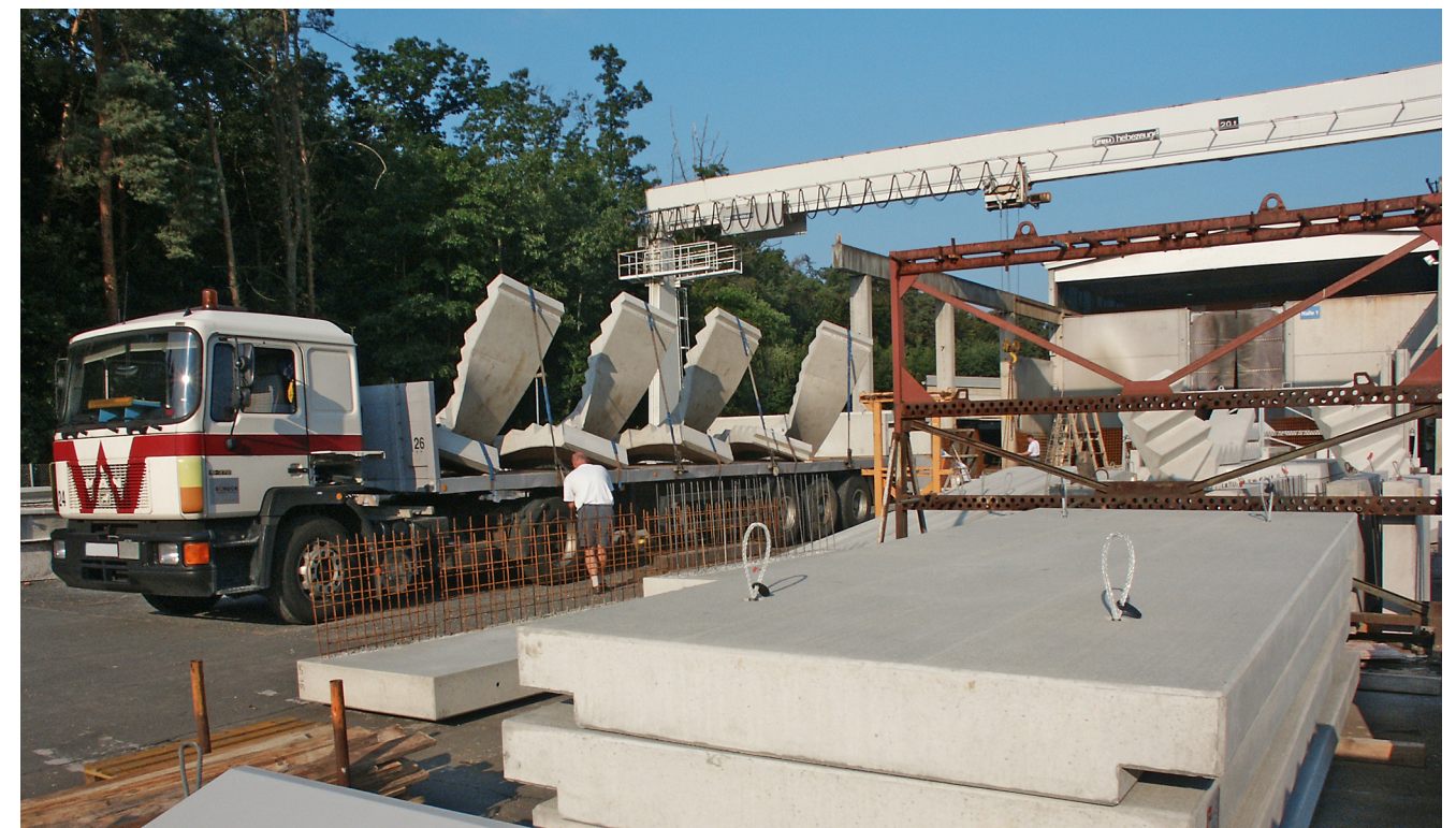
Einsatz der Seilschlaufe SF im Elementwerk.
