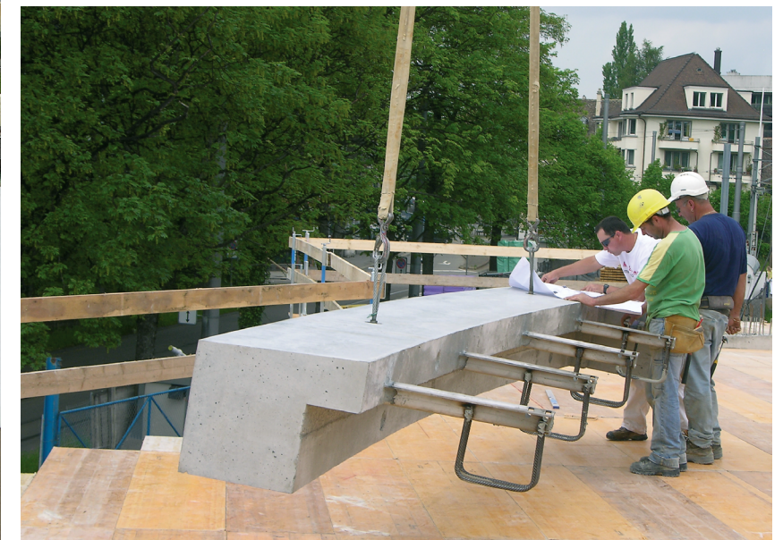
Versetzarbeiten der vorfabrizierten Dachrandelemente. Eléments préfabriqués en béton posés avant le bétonnage de la dalle.
