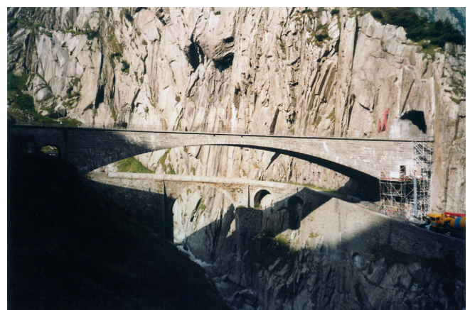
Sanierung Teufelsbrücke im Kanton Uri Assainissement du pont du diable dans le canton d'Uri
